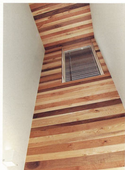
患者用トイレ内部の見上げ
